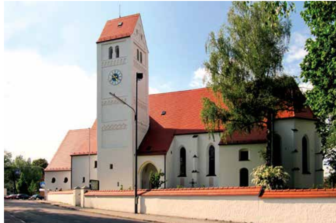
Das älteste Gebäude Aubings, die Kirche St. Quirin.
